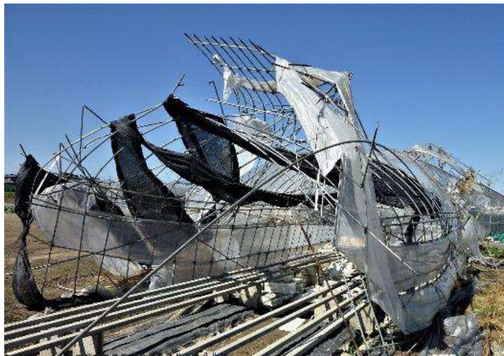
台風被害の様子
