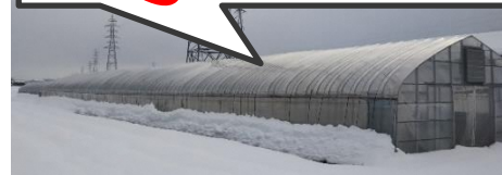
農業用ハウスの補強対策済み
