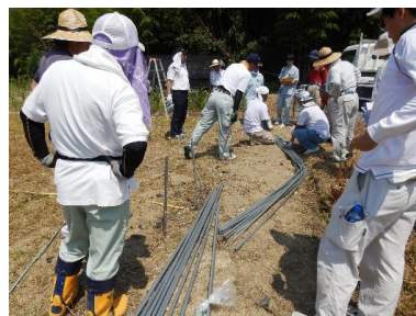
災害復旧の取組実証
