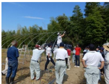
自力施工講習会
