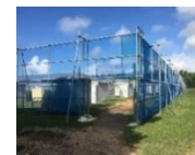
防風ネットの設置
