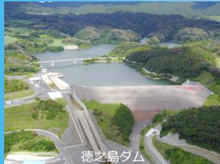
徳之島ダム 写真提供: 鹿児島県
