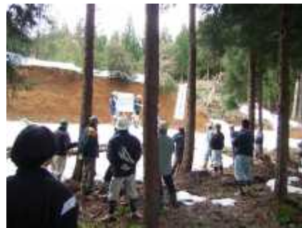
林道・作業道完工踏査 (雄神地区森林振興会)
