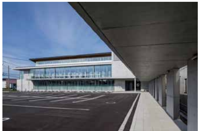
外部通路のイメージ（左：芽室町、右：砺波市立砺波図書館）
