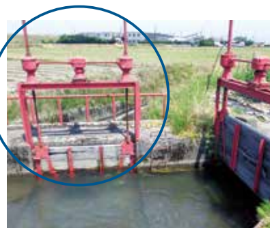
諏訪堂水路水門
