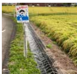
転落防止柵が設置
