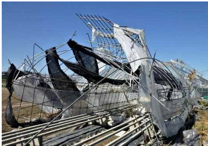
台風被害の様子
