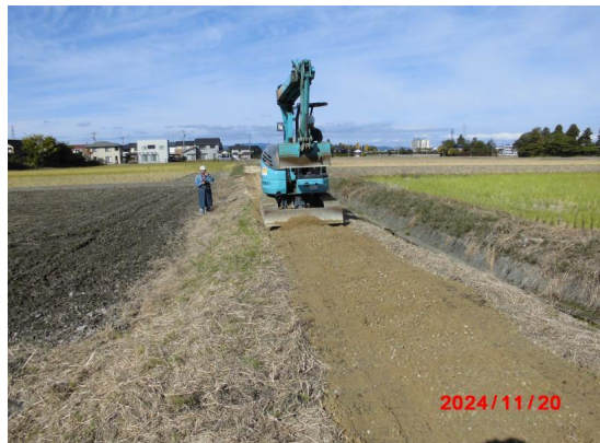
敷砂利の均し
