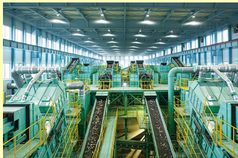
(株) 富山環境整備 高度選別施設
