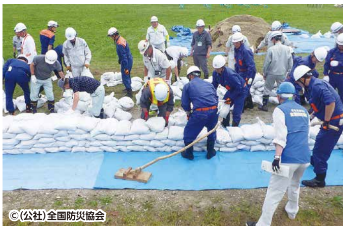
水防専門家の指導 積み土の土工(杭省略型)
