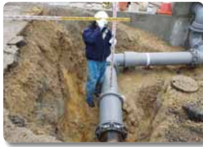
上水道管耐震工事
