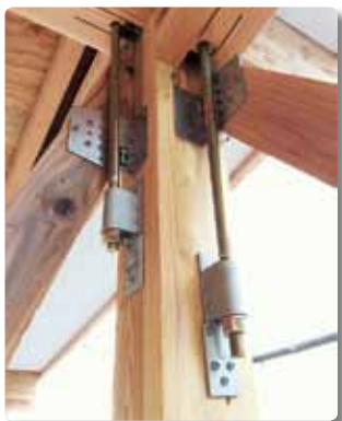
建物の耐震補強
