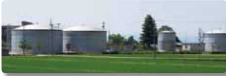
上中野配水場
