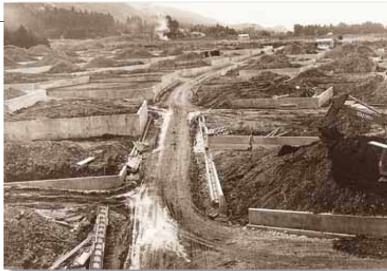
着々と進む岩黒団地造成工事(昭和46年)
