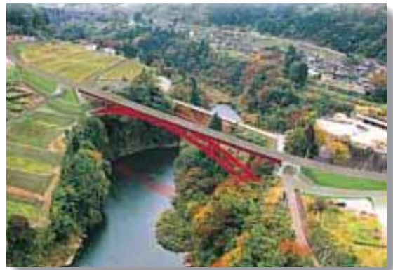
主要地方道富山庄川線「藤橋」起工式
