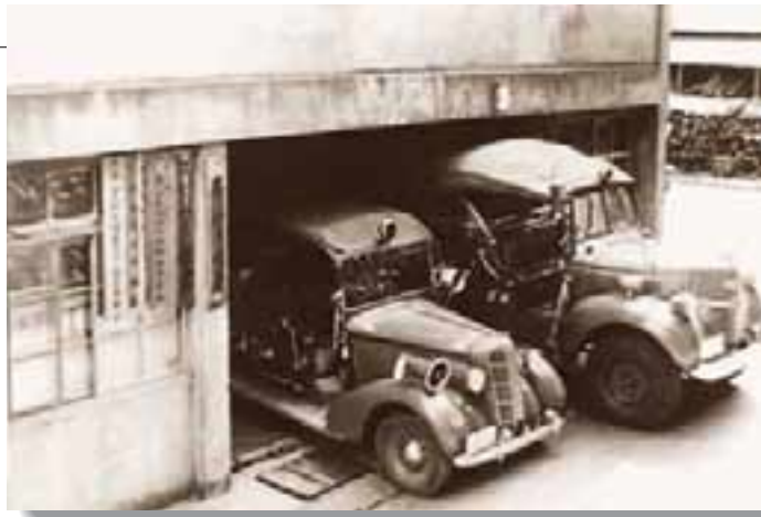
庄川町消防署(昭和29年)
