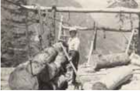
木材の切出作業(昭和初期) 大井さんより提供
