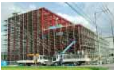
平成13年10月完成予定の種子消毒施設
