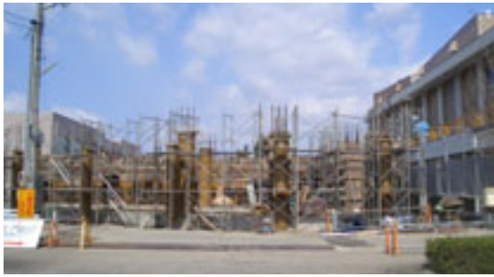
建設中の「庄川健康プラザ」
