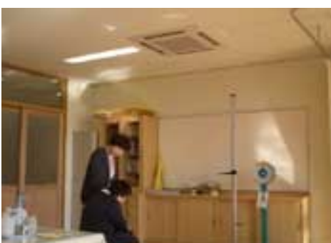
砺波東部小学校保健室に設置のエアコン
