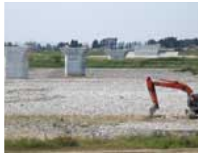
国道359号線砺波東バイパス事業 (建設中の仮称新長大橋)
