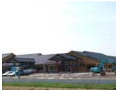
建設中の北部苑・北部デイサービスセンター
