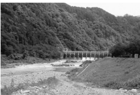
庄川合口ダム
