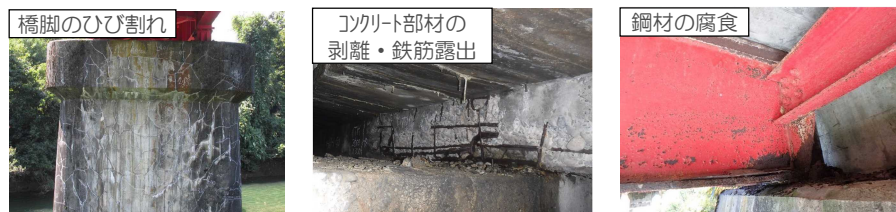
(対象橋梁の対策を要する損傷例)
