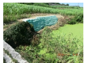
土のうによる崩落箇所の拡大防止
