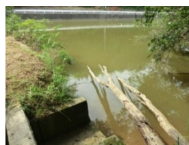
土砂や流木等の撤去
