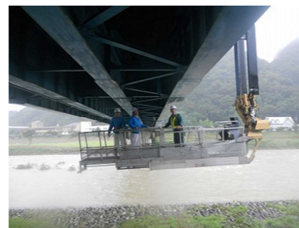
（橋梁下面の点検状況）
