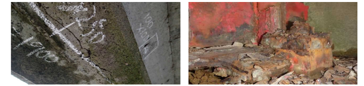
コンクリート橋のひびわれ 鋼材（支承部）の腐食 （修繕対策を要する橋梁の損傷例）
