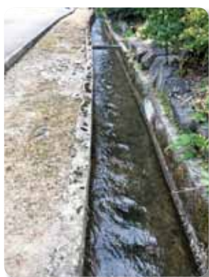
老朽化が見込まれる用排水路
