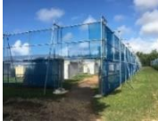
防風ネットの設置
