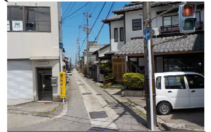
市道新富町3号線 県から市へ管理移管
