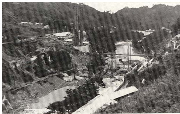
工事中の小牧ダム
