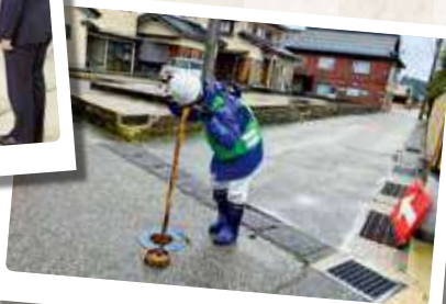
仕切弁を操作して漏水がないか確認▶
